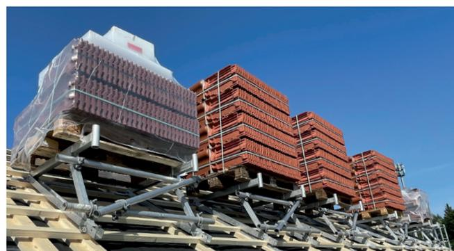
Il **pianale Alu** è uno degli strumenti di lavoro più importanti per il carpentiere. Caratterizzato dal suo peso contenuto, prodotto completamente in alluminio, offre un piano d'appoggio fino a 1,10 m per pendenze dai 20° ai 60°, grazie alla regolabilità tramite un reticolo di fori. Il suo impiego consiste nel creare un piano orizzontale sulla copertura inclinata per il deposito di materiali come tegole, mattoni, legname e utensili.
