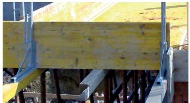
Die **Schalstütze** ist ein modernes Werkzeug, mit dem Sie verschiedene Auffüllarbeiten an Decken oder Treppen schnell, bequem und sicher durchführen können. Die Halterung ist mit Löchern zur Befestigung an den Holzbrettern ausgestattet, so dass sie immer wieder verwendbar ist und Holzverschwendung vermeidet. Die Stütze ist für eine Deckenhöhe von bis zu 30 cm ausgelegt (Achsabstand siehe Tabelle). Für die Sicherheit am Arbeitsplatz kompatibel mit dem Universalen Seitenschutz (Seite 28).
