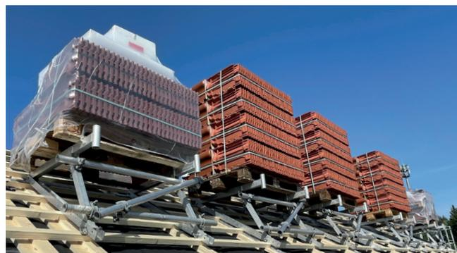
Der **Dachständer Alu** ist eines der wichtigsten Arbeitsmittel für den Zimmermann. Das vollständig aus Aluminium gefertigte Produkt zeichnet sich durch sein geringes Gewicht aus und bietet dank seiner Verstellbarkeit über ein Lochraster eine Auflagefläche von bis zu 1,10 m für Neigungen von 20° bis 60°. Er dient der Schaffung einer horizontalen Ebene auf dem Schrägdach für die Lagerung von Materialien wie Ziegeln, Dacheindeckung, Holz und Werkzeugen.
