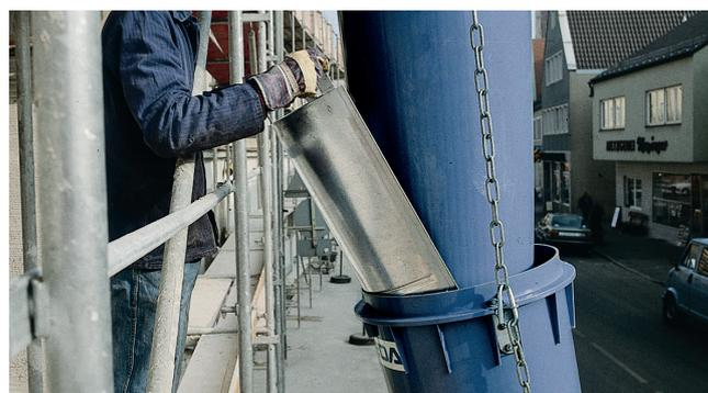
**GEDA-Bauschuttrutschen** bieten ein hochwertiges Schuttrutschensystem. Verschiedene Arten von Stützen ermöglichen die Montage auf jeder Unterkonstruktion, um effizient und schnell in der Montage zu sein.
