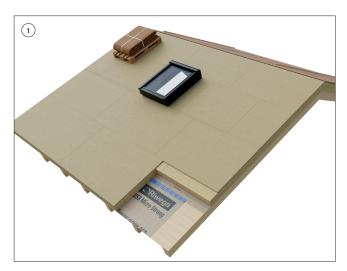
Colocar la paleta que contiene la membrana plegada en la parte superior del faldón a cubrir
