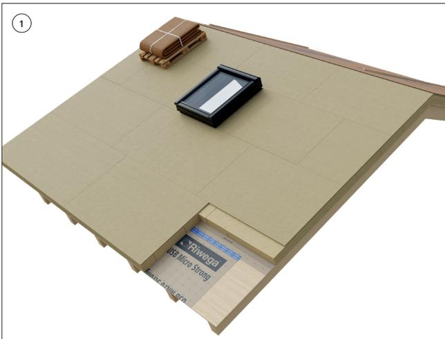
Legen Sie die Palette mit der zusammengefalteten Membrane in die obere Ecke der abzudeckenden Dachfläche
