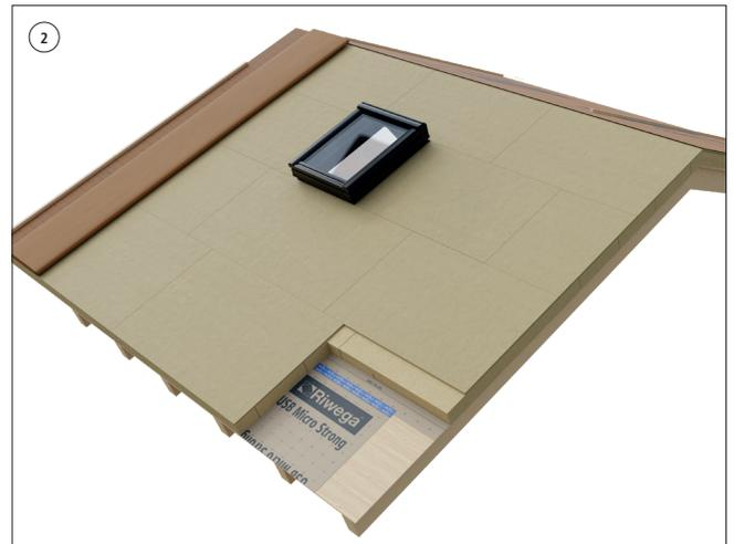
Breiten Sie die Membrane nach unten aus und befestigen Sie die erste Konterlatte an der Stirnkante
