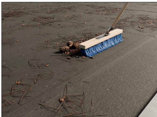
Pulire il sottosuolo dallo sporco e dai residui di materiale.
